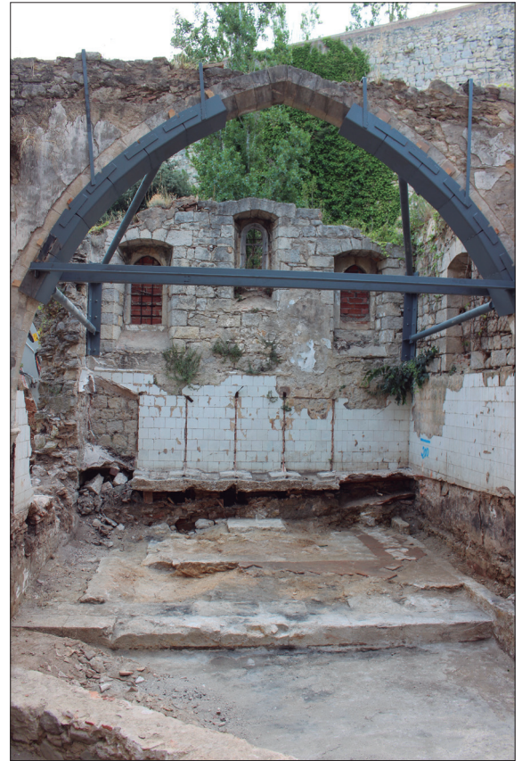
Fig. 6. Vista des de l'est de les restes de la capella de Sant Domènec un cop finalitzats els treballs arqueològics.
