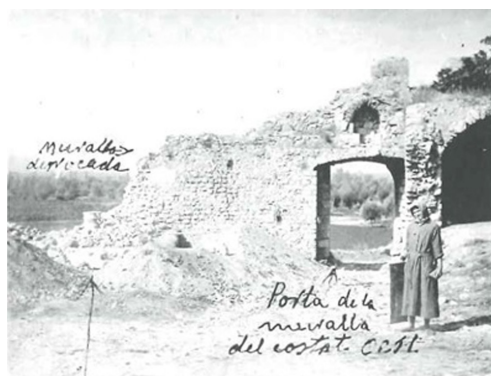
Fig. 6. Fotografia on s'observa la muralla oest enderrocada (Gandia 1923, 145). Font: MAC-Empúries.
