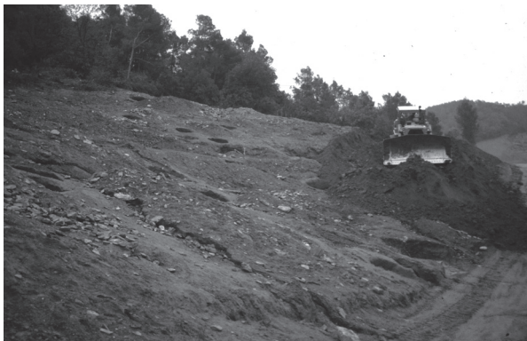
Fig 11. Destrucció del sitjar just després de finalitzar l'excavació arqueològica.
