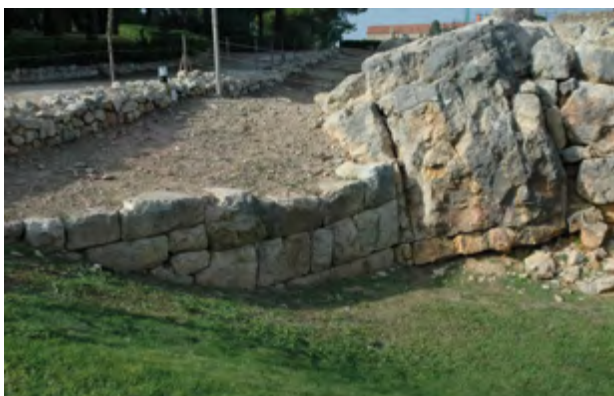
Figura 10. Aspecte de les restes conservades de la muralla diagonal, adossada a la torre de l'angle sud-oest de la Neàpolis, i que unia en un sol recinte les dues ciutats. Fotografia: MAC-Empúries
