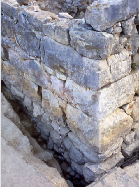
188 i 189. Empúries, Neàpolis. Diferents vistes de les rases de fonamentació de la torre occidental de la muralla meridional d'Emporion. Va caldre una enorme trinxera per poder treballar convenientment i col·locar els blocs ingents de la fonamentació. Observem, també, un canvi en el tipus de parament, el fundacional, amb blocs de pedra més petits, sense ordenar d'una part que no s'havia de veure, i la part superior, d'un imponent parament ciclopi perfectament disposat.
