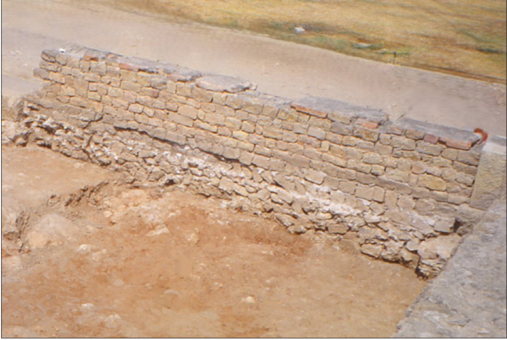
193. Empúries, fòrum. El mur d' opus vittatum s'alça sobre un sòlid fonament irregular (no s'havia de veure). Damunt del sòcol, coronant la paret, una sèrie de tegulae amb la rebava cap avall, que preparaven una excel·lent plataforma per rebre la part superior del mur de tàpia. Fixem-nos com, entre tègula i tègula hi ha un espai pels posts perpendiculars de suport de la tapiera. Fixem-nos, també, que el mur de vittatum acabava a distàncies predeterminades amb uns grans carreus parallelograms de gres que donaven solidesa i consistència al conjunt, davant per davant dels quals a una distància fixa es col·locaven les columnes i el corresponent capitell, també de pedra sorrenca.
