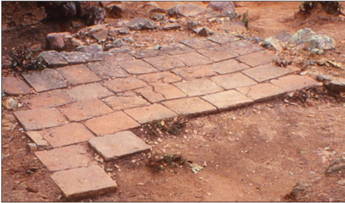
153. Mas Carbotí. En aquest exemple es pot observar un paviment fet amb rajols sesquipedales (d'un peu per un peu i mig).
