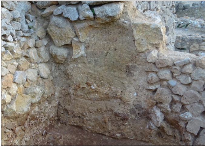
4. Empúries, Neàpolis. Toves disposades sobre un sòcol de pedra en un edifici privat de cap al 450 aC.
