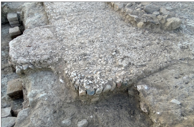
135. Collet de Sant Antoni. Si bé habitualment el morter es barrejava amb picadís de ceràmica, en alguna ocasió eren pedres o fragments de pedres polides blanques.
