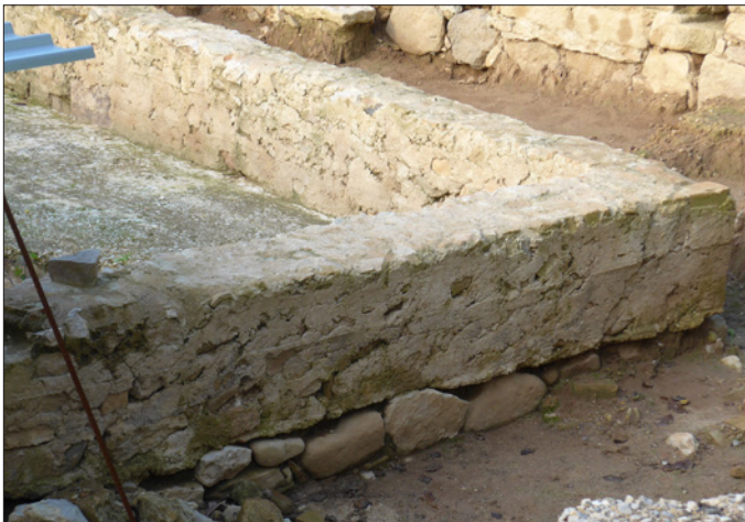
117. Pla de l'Horta. Murs d' opus caementicium on podem observar el senyal deixat per l'encofrat de fusta.
