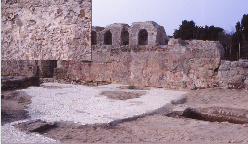
111. Empúries, Neàpolis. El mur septentrional del caldarium del balneion hellenístic que ocupava els darreres de l'àgora urbana, molt sencer, fou obrat amb opus caementicium a l'entorn del 100 aC. Intacte, després d'uns quants segles d'abandonament, fou aprofitat per bastir una cella memoriae a finals del segle IV. A la fotografia se'n pot apreciar també un detall on s'observa la seva composició.
