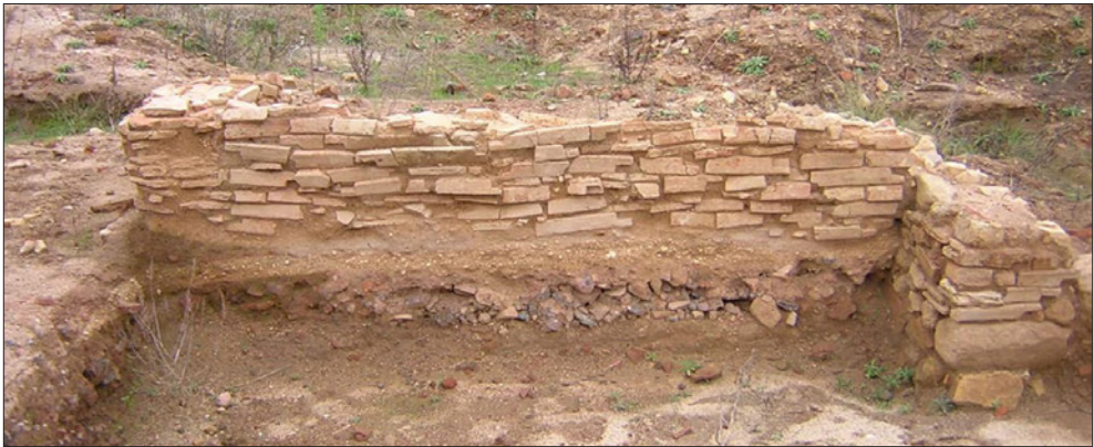
95. Collet Est. Sòcol d'un mur de tegulae sense fonaments.
