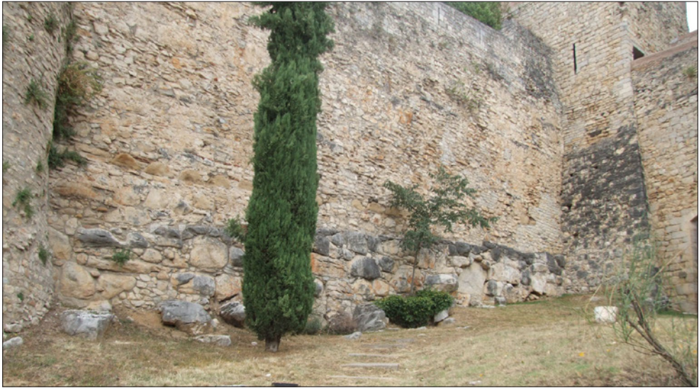
68. Gerunda. Algun dels sectors de la muralla fundacional és de tipus clarament ciclopi, amb blocs enormes i falques de pedra omplint els espais buits.
