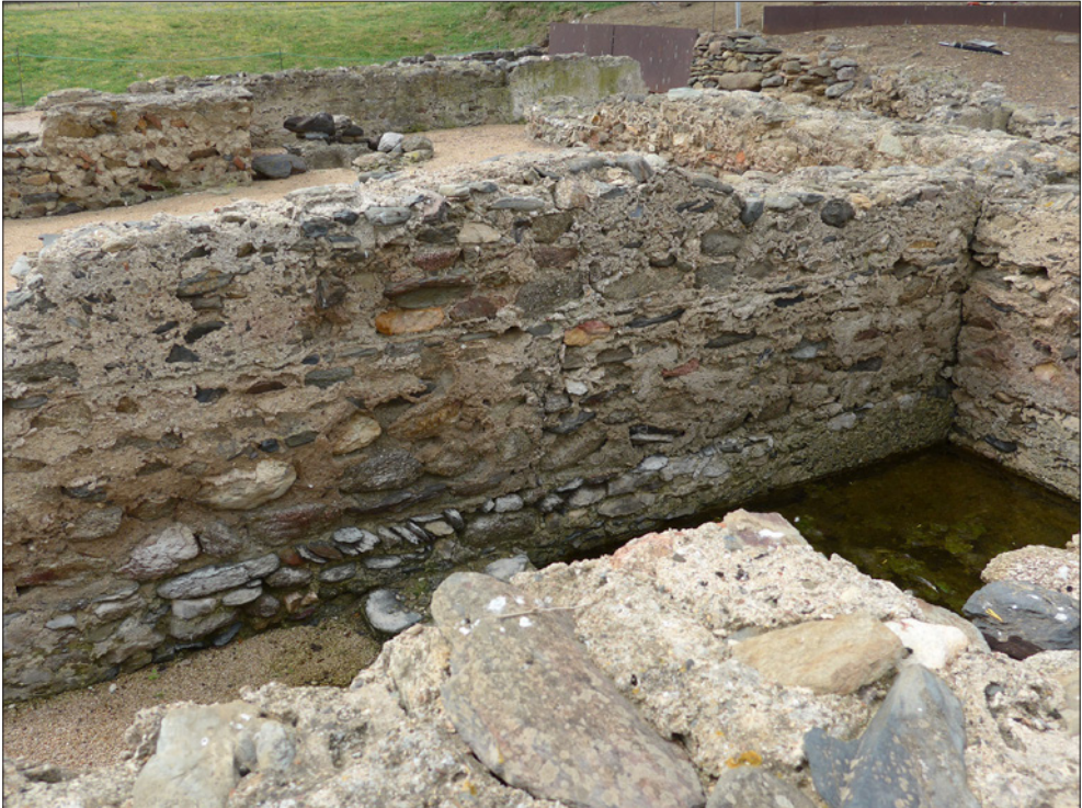
115. Ciutadella de Roses, Edifici A. Al uicis tardo-antic de Roses, els murs de la factoria de salaons es van obrar amb opus caementicium . A la imatge es poden apreciar fins i tots les empremtes de l'encofrat de fusta que es va fer servir per bastir-lo.
