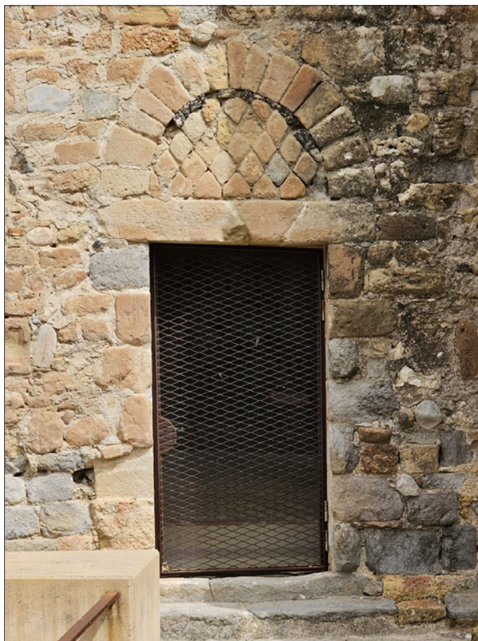
88. Sant Miquel de Fluvià, cenobi. Entre la llinda i l'arc d'aquesta portella que comunicava l'església i el claustre, constatem l'ús d'un bell parament d' opus reticulatum amb una funció clarament ornamental (segles XI-XII).
