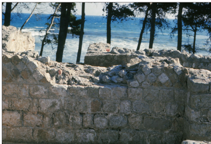
87. Empúries, Neàpolis. Únic exemple conegut (i parcial) d' opus reticulatum documentat en tot aquest territori.
