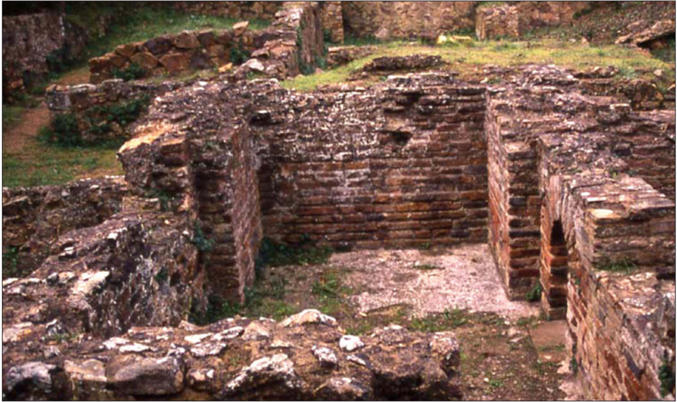
17. Ametllers. Murs de rajol del balneum alt-imperial obrats exclusivament i completament amb testae .
