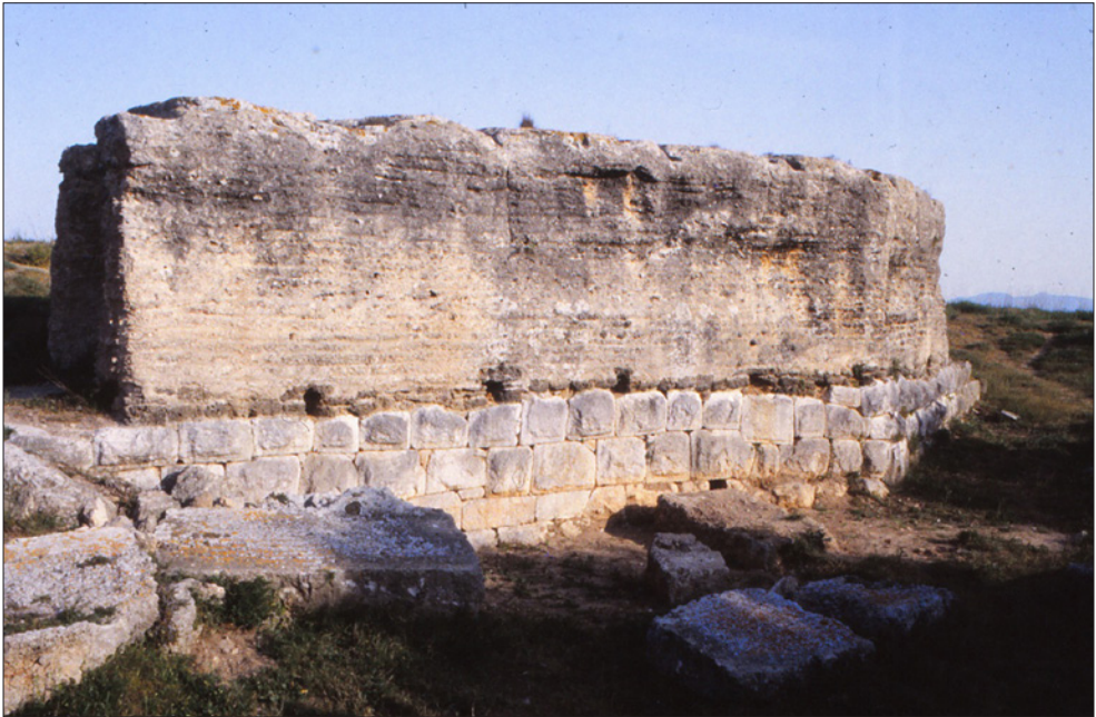
112. Empúries, muralla meridional de la ciutat regular. Ús de l' opus caementicium sobre un sòcol d' opus siliceum .
