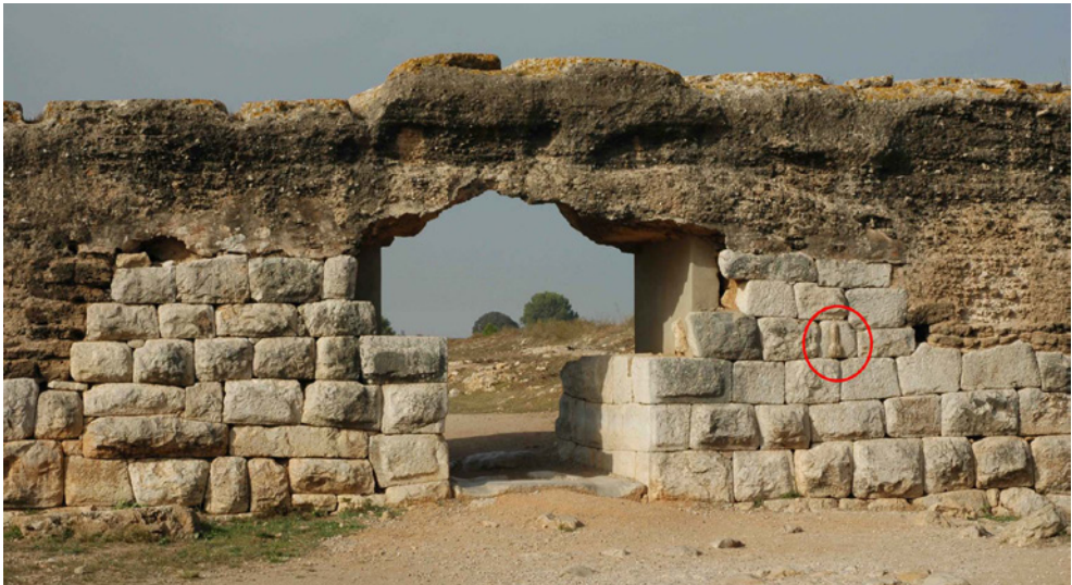
65. Empúries. Tram de la muralla meridional de la ciutat regular amb un magnífic parament d' opus siliceum que servi de sòcol per a un alçat d' opus caementicium . Marcat en vermell, el fallus apotropaic esculpit en un dels carreus.
