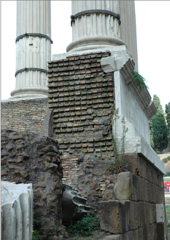
157. Roma, temple d'Apol·lo Sosianus. L'edifici, parcialment d' opus testaceum , era aplacat de marbre blanc de Luni tal com les columnes i capitells. El resultat era espectacular, més barat i d'una enorme solidesa.
