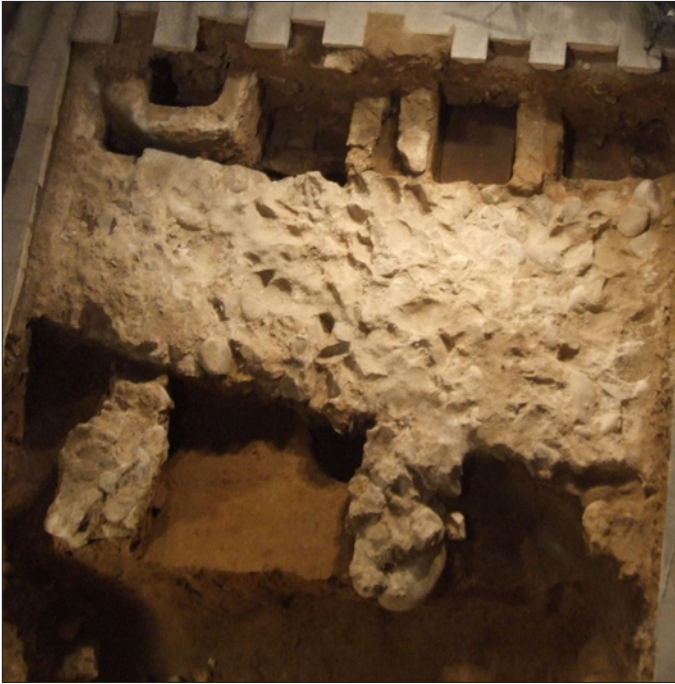
114. Girona, Sant Feliu. La resistència del caementicium permetia construir murs d'una enorme solidesa. Un bon exemple és el mur de l'absis de la basilica paleocristiana (a l'entorn del 600) descoberta al subsòl del presbiteri del temple martirial.
