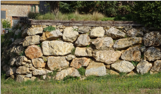
63. El parament ciclopi es fa servir encara en temps presents, per exemple en la creació de grans murs de contenció.
