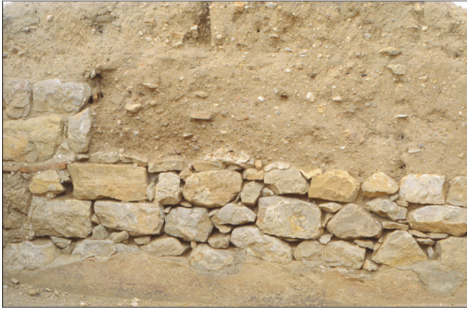
12. Empúries, casa romana 2A. La tàpia es disposava sempre sobre un sòcol de pedra per evitar el contacte directe amb el terra i protegir-la d'humitats.
