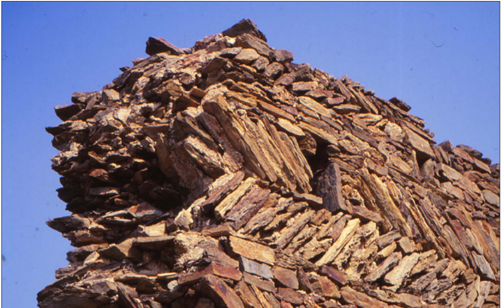
89. Castell de Bufalaranya, Roses. Parament d' opus spicatum , a bastament usat en aquella fortificació de datació imprecisa (segles X o XI).
