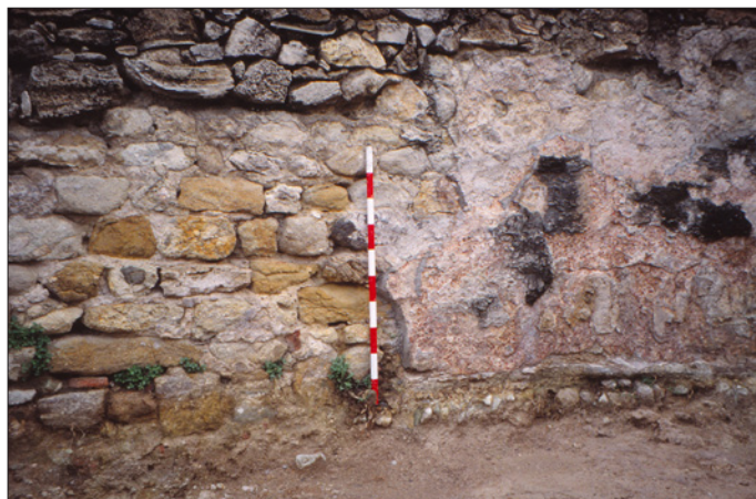
159. Puig de Sant Grau. Mur de tramuntana del porticat que envoltava la gran natatio del balneari amb un recobrint impermeable d' opus signinum .
