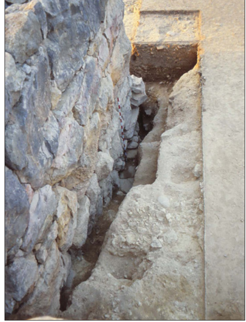
188 i 189. Empúries, Neàpolis. Diferents vistes de les rases de fonamentació de la torre occidental de la muralla meridional d'Emporion. Va caldre una enorme trinxera per poder treballar convenientment i col·locar els blocs ingents de la fonamentació. Observem, també, un canvi en el tipus de parament, el fundacional, amb blocs de pedra més petits, sense ordenar d'una part que no s'havia de veure, i la part superior, d'un imponent parament ciclopi perfectament disposat.
