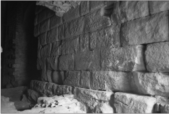
71. Girona, interior del castell de Gironella, torre núm. 2. Parament d' opus quadratum amb els carreus encoixinats (època tetràrquica).
