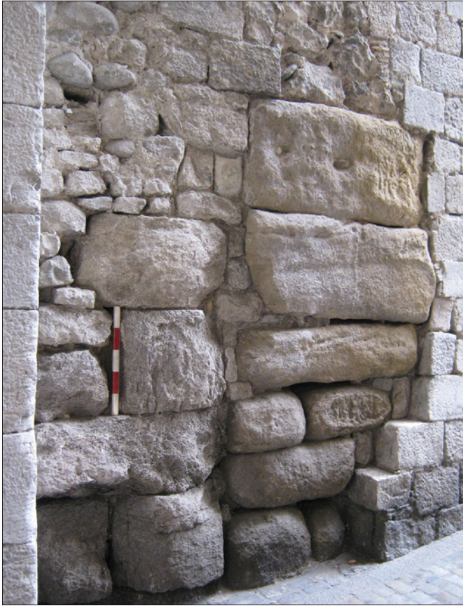
98. Girona. Sobreportes. Ús de grans blocs procedents del fòrum urbà en les reformes de la porta nord de la ciutat d'època carolíngia (finals del segle VIII).
