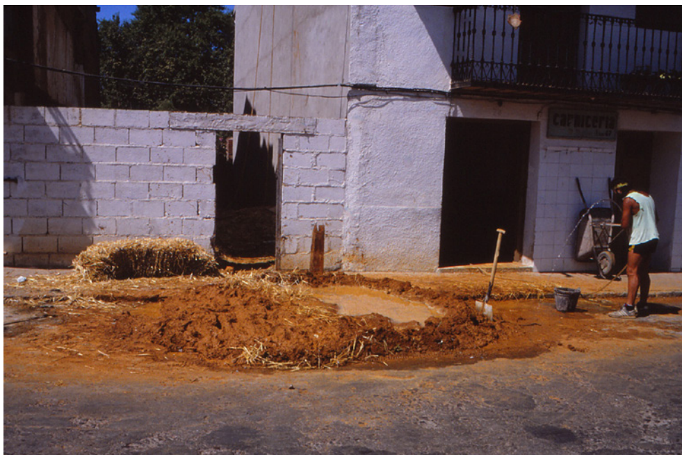
10. Tudela de Duero (Valladolid). Preparant tàpia per bastir un mur: bassa amb aigua, argila i palla, amb la galleda preparada per portar la pasterada on convingui. La manera d'obrar no ha canviat des dels orígens.
