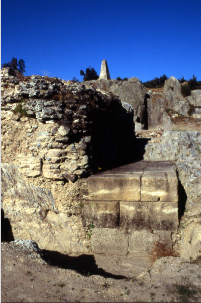
74. Panissars, trofeu de Pompeu. Exemple d' opus quadratum que conviu amb altres tipus de paraments, en aquest cas, opus caementicium .
