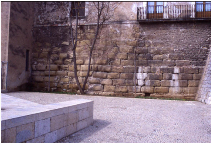
72. Gerunda. Pany de muralla d' opus quadratum del sector de la plaça de Sant Domènec (època tetràrquica).
