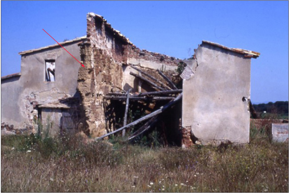
9. El Far d'Empordà. Exemple de la utilització de la tova en un edifici d'època moderna.
