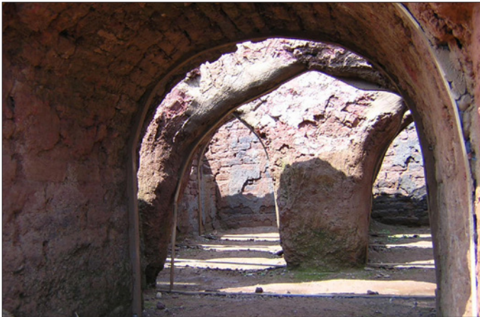
44. Collet Est. Arcs i voltes de rajol sencers d'un dels forns de la terrisseria.
