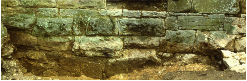
69. Gerunda, interior del castell de Gironella, torre núm. 2. Basament fundacional (baixa república) d'un bell parament d' opus siliceum amb els carreus tallats amb cura, tots diferents però pensats per encaixar-los.
