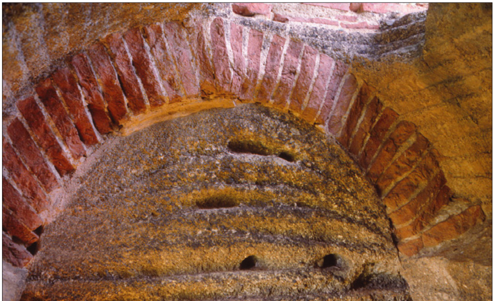
38. La Torratxa. Exemple d'utilització de rajols en combinació amb opus caementicium .
