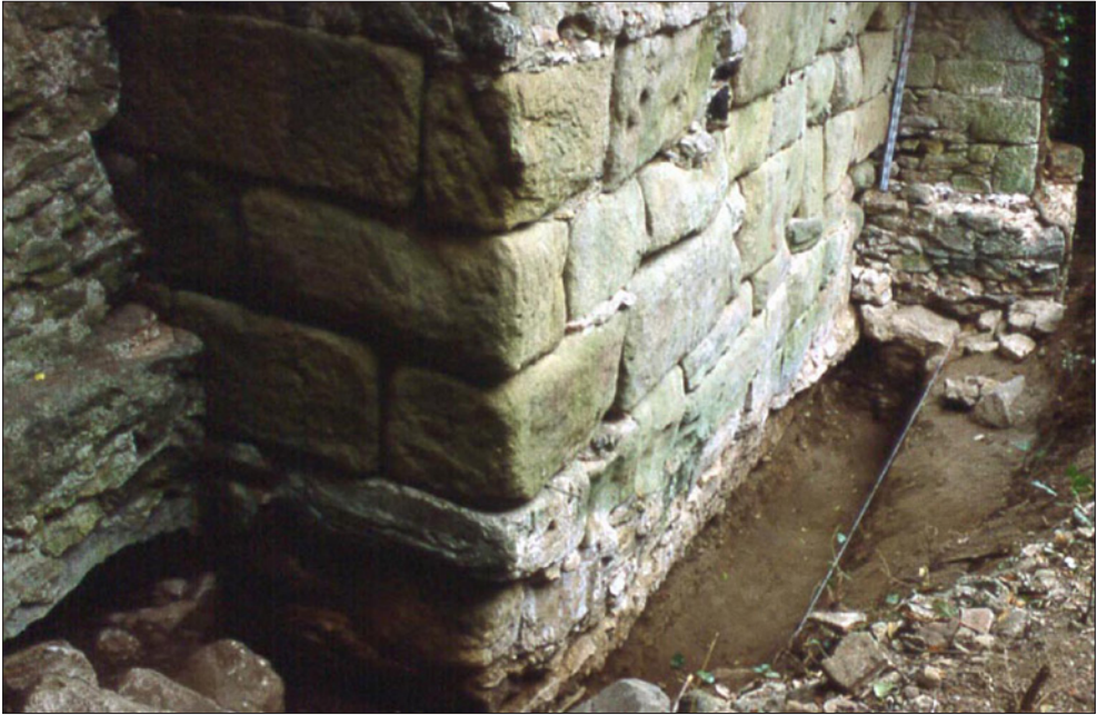
99. Girona, torre núm. 3. Fou obrada, en la part inferior, amb material d'aprofitament de grans blocs de gres i peces de marbre d'un antic arc —o porta— urbà (finals del segle VIII).
