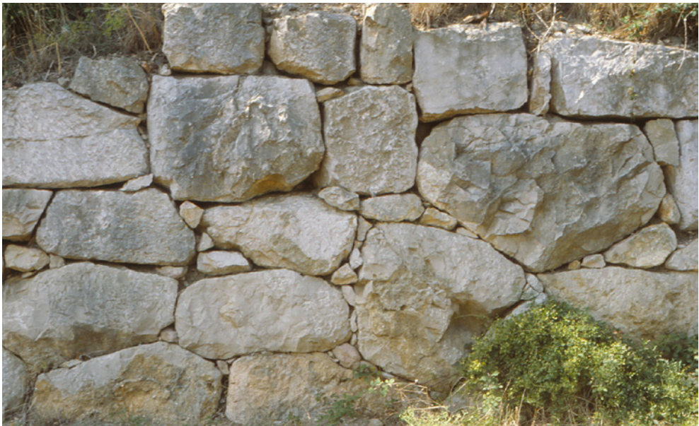
66. Empúries. Tram de la muralla oriental de la ciutat regular. L' opus siliceum combina blocs grans de pedra amb petites falques que s'encaixen en els espais buits entre els carreus.
