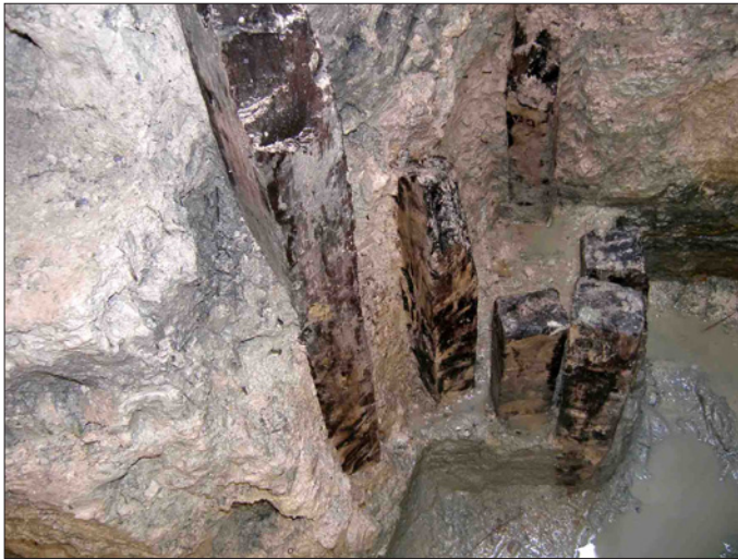
169. Puig de Sant Grau. Posts de fusta clavats en la capa freàtica del subsòl de l'edifici termal de Caldes de Malavella, per sostenir la fonamentació.
