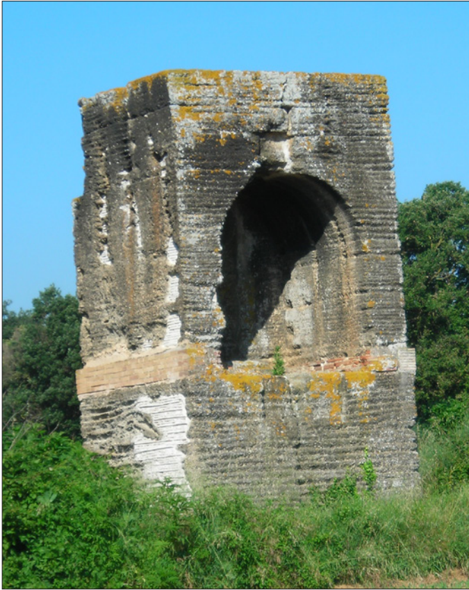
108. La Torratxa. Estructura d' opus caementicium del monument funerari. El color fosc és conseqüència de l'ús de pedra volcànica mòlta.
