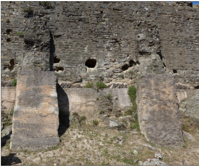
116. La Clusa Alta. Aquesta imponent fortalesa que defensava el costat oriental de la via romana és una mostra excellent d'un parament d' opus caementicium que féu servir, puntualment, l'ús de carreus escairats de pedra en determinades cantonades.
