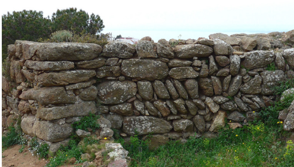
93. Puig de les Muralles a Puig Rom. Parament interior de la muralla a prop de la porta principal d'accés amb uns d'una mena de disposició dels blocs en espiga.
