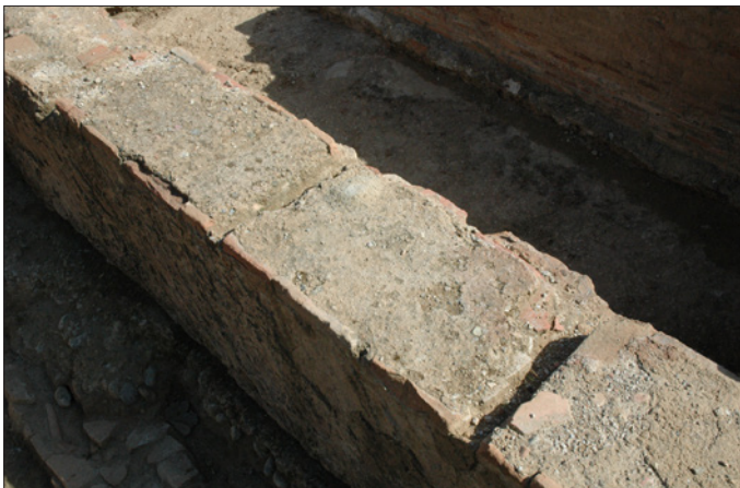
14. Pla de l'Horta. Podem observar els ancoratges que es van utilitzar per sostenir la tàpia, obrats amb teglulae i els encaixos de les posts perpendiculars que sostenien la tapiera.
