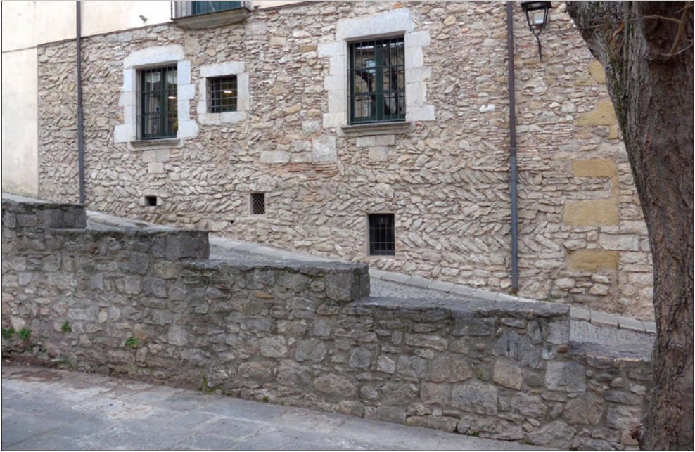
94. Girona, costat meridional de la plaça dels Lledoners. Parament carolingi d' opus spicatum en un casal amb la façana obrada amb blocs d'aprofitament de pedra sorrenca.
