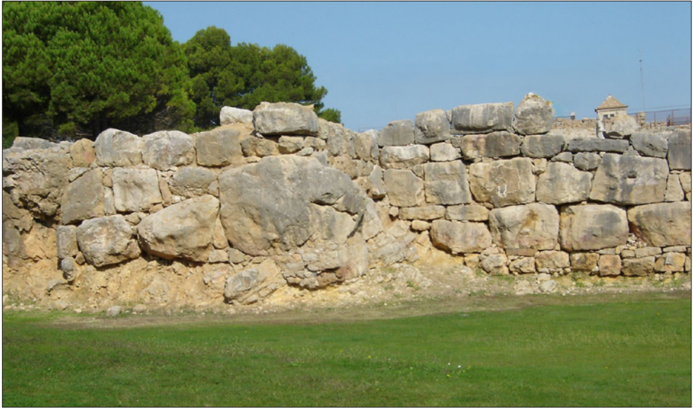
60. Empúries, Neàpolis. Parament ciclopí del tram meridional de la muralla urbana (vers el 150 aC).
