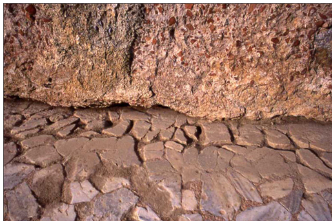
149. Empúries, Neàpolis. El gran mur d' opus caementicium del costat de tramuntana del caldarium del balaneion correspon a un segon moment de la història d'aquell edifici. Observem com es disposà directament sobre el sòl de segmentatum .
