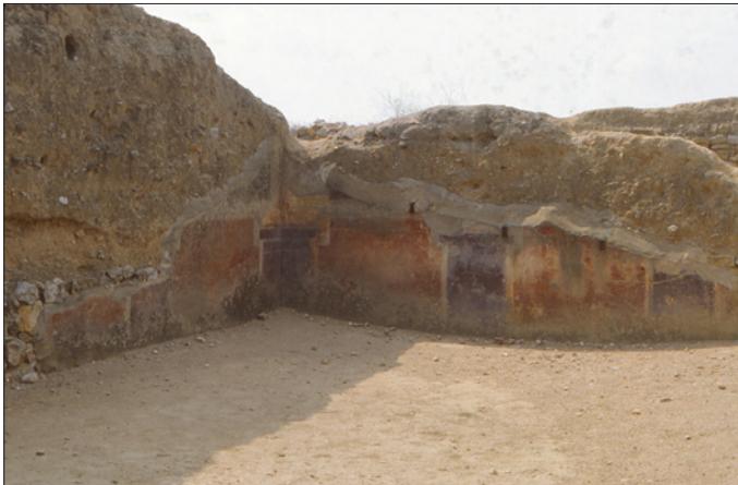
13. Empúries, casa romana 2A. Tant el sòcol de pedra com la pròpia paret de tàpia es revestien (remolinat de calç pintat, aplacat de pedra, opus musivum ,...) per aconseguir un acabat uniforme.
