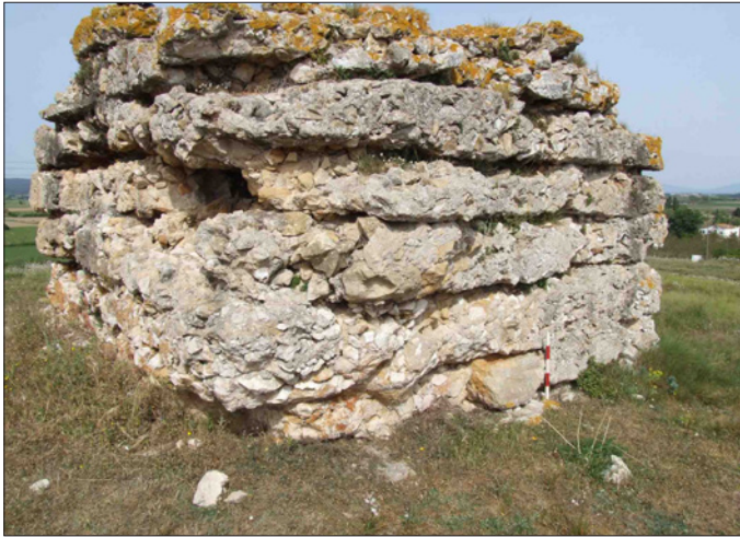
109. Empúries, el Castellet a les Corts. Dalt d'aquell turó, l'ànima interior d' opus caementicium d'un probable monument funerari d'època imprecisa. És segur que l'exterior havia estat de carreus regulars de gres, robats per aprofitar-los.
