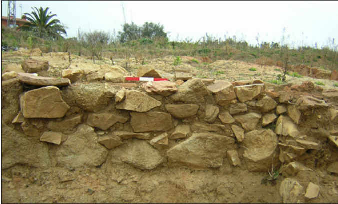
79. Collet Est. Exemple de mur de pedra seca lligat amb fang d'una de les construccions de la bòbila.
