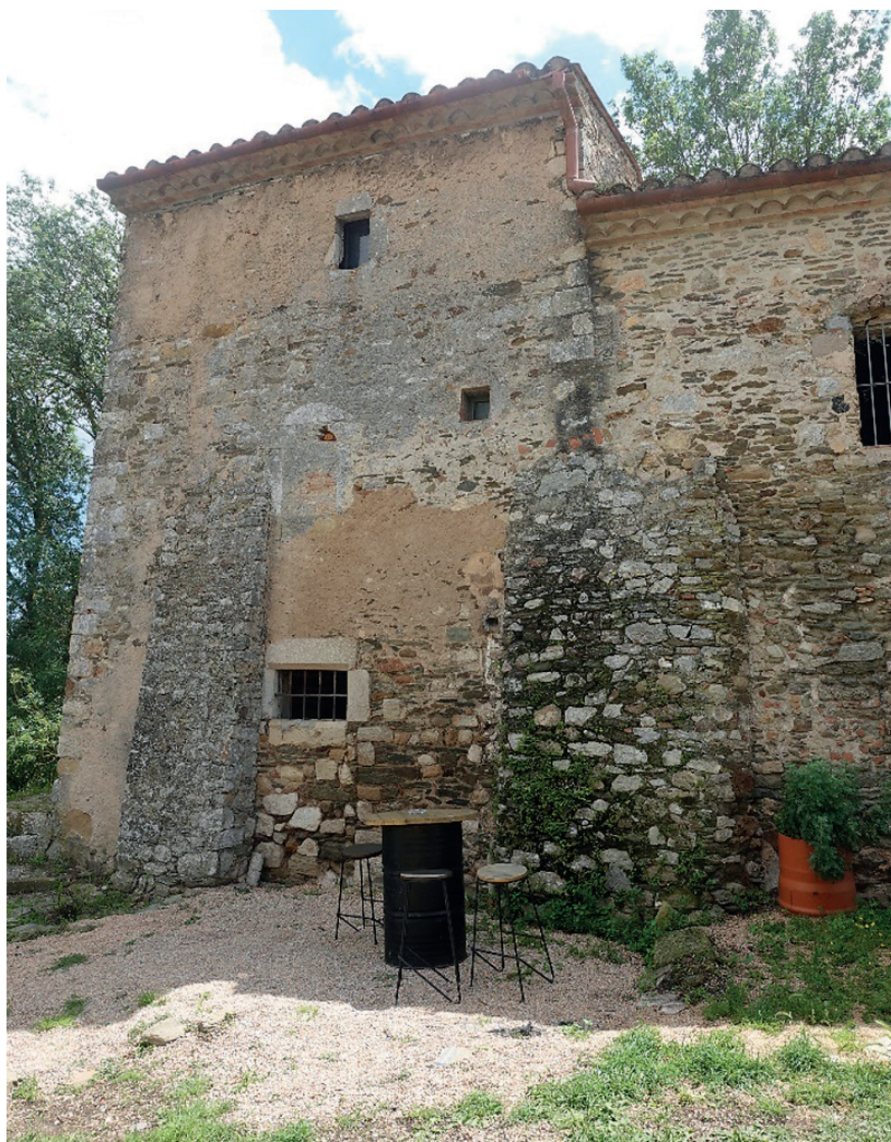
Figura 36. Aspecte actual de la façana nord de la torre.
