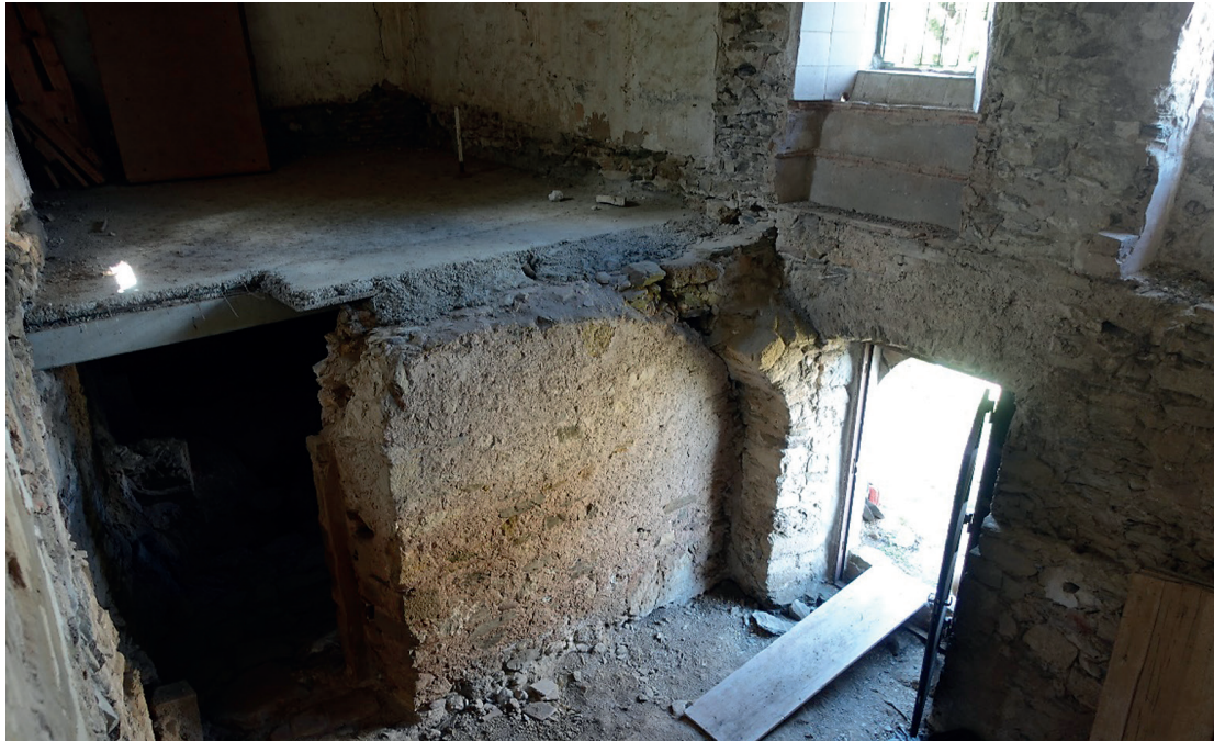
Figura 40. Detall interior del pati (cambra número 4) amb la porta d'entrada i l'arrencament de l'arcada que comunicava amb la cambra número 6.
