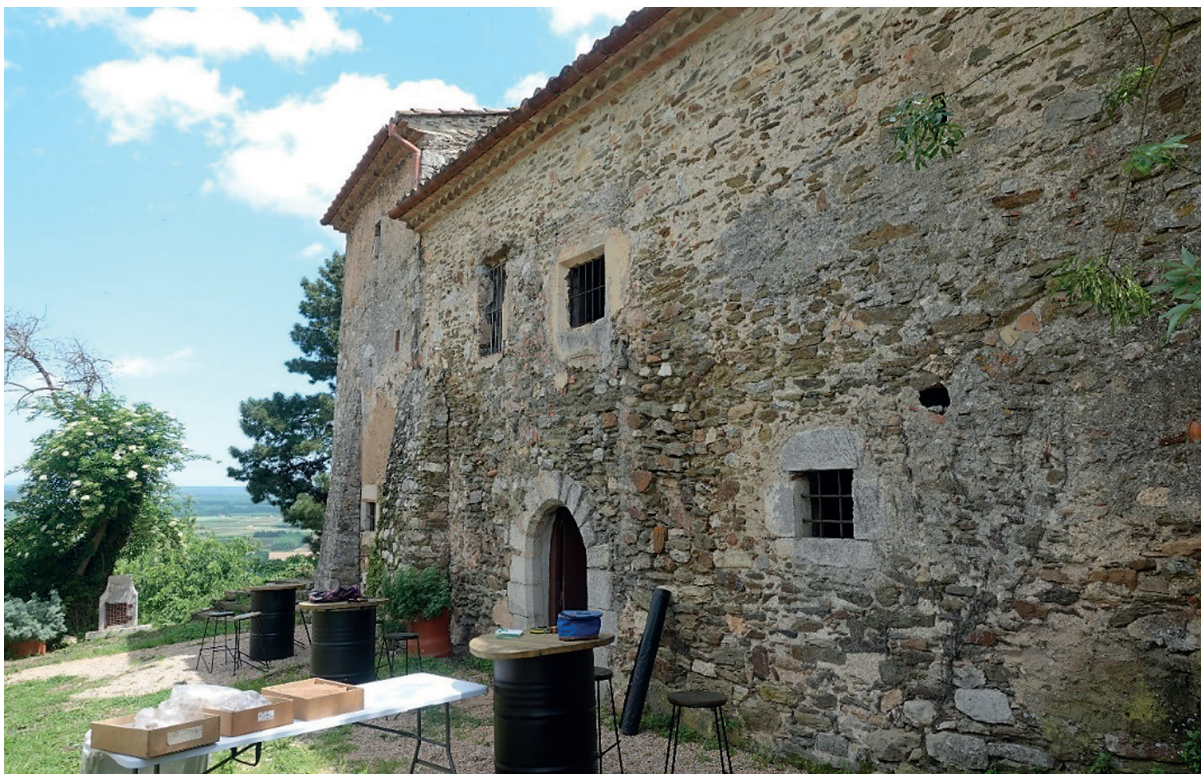
Figura 25. Aspecte general de la façana nord de l'antiga rectoria.
