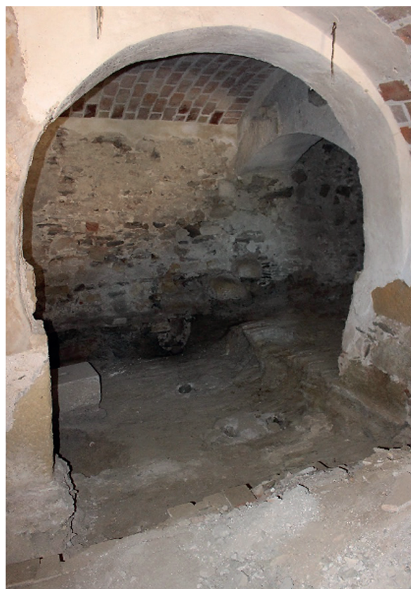
Figura 28. Cambra 2 des del nord, amb l'arcada que la separa de la cambra 1.
