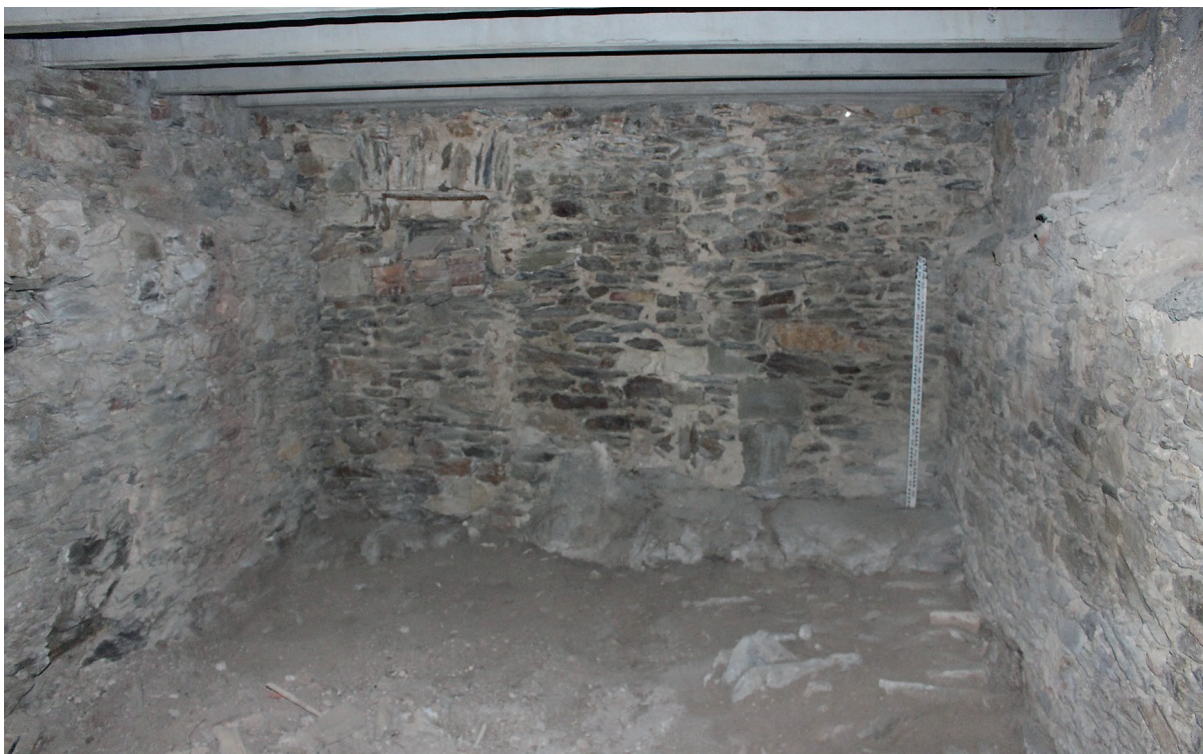
Figura 32. Fotografia de les cambres 6 i 7, avui arranjades com una única estança sense discontinuïtats..
