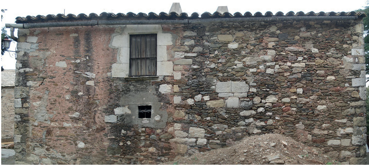
Figura 22. Façana meridional de can Bota. A la dreta de la finestra s'aprecia la junta vertical de la cantonada que marcava la partió entre el celler (esquerra) i el precedent directe de can Bota (dreta).
