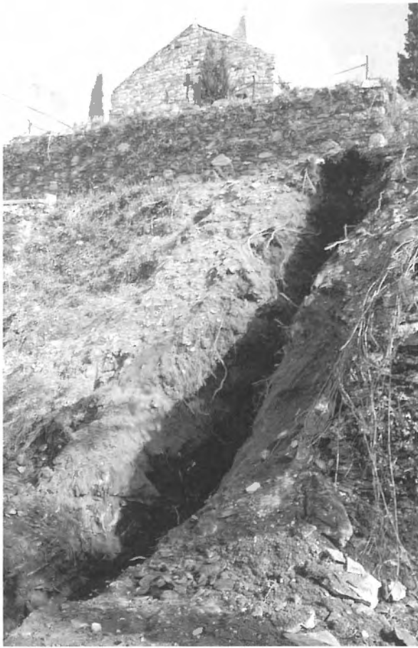
Fig 17. El sector 1 durant les obres d'ampliació del cementiri (1193).
