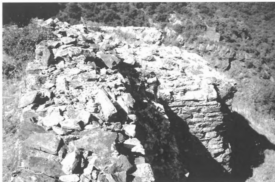
Fig 122. La Clusa Alta. Detall del mur i torre del costat septentrional.
