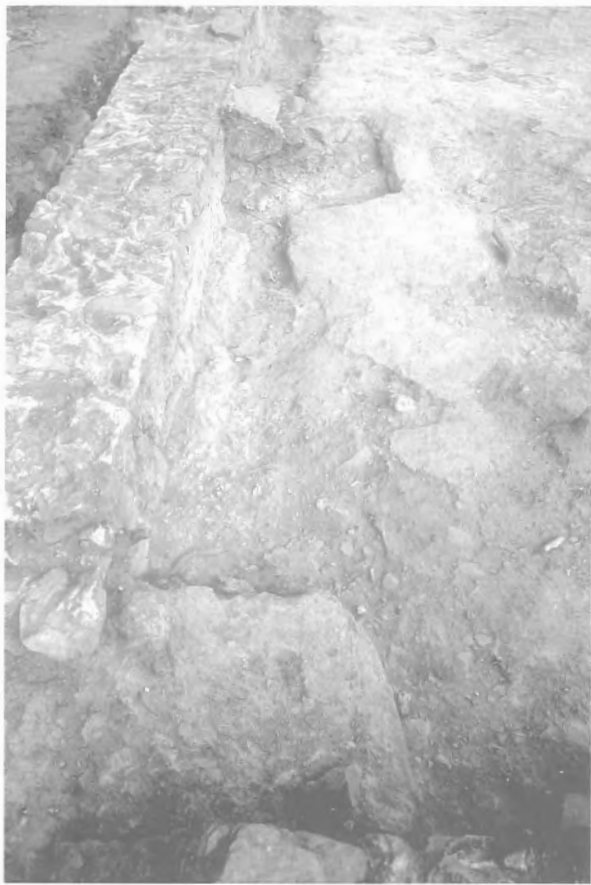
Fig. 39. Edifici I. Àmbit 4. Mur de ponent i paviment original (fase I) retallat per encaixar-hi els basament de pilastres de sosteniment (fase II).
