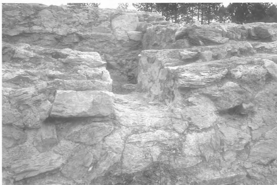
Fig 27. Edifici I. Àmbit 24. Mur de migdia. Detall de la tècnica constructiva i d'un desguàs integrat en l'obra original recobert interiorment amb morter hidràulic.
