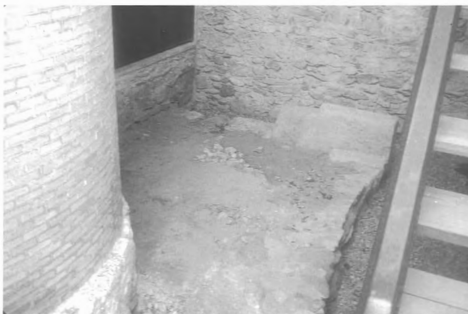
Fig 57. Edifici IV. Costat oriental conservat per sota de l'obra romànica. Observeu a l'angle uns blocs de sorrenca in situ .
