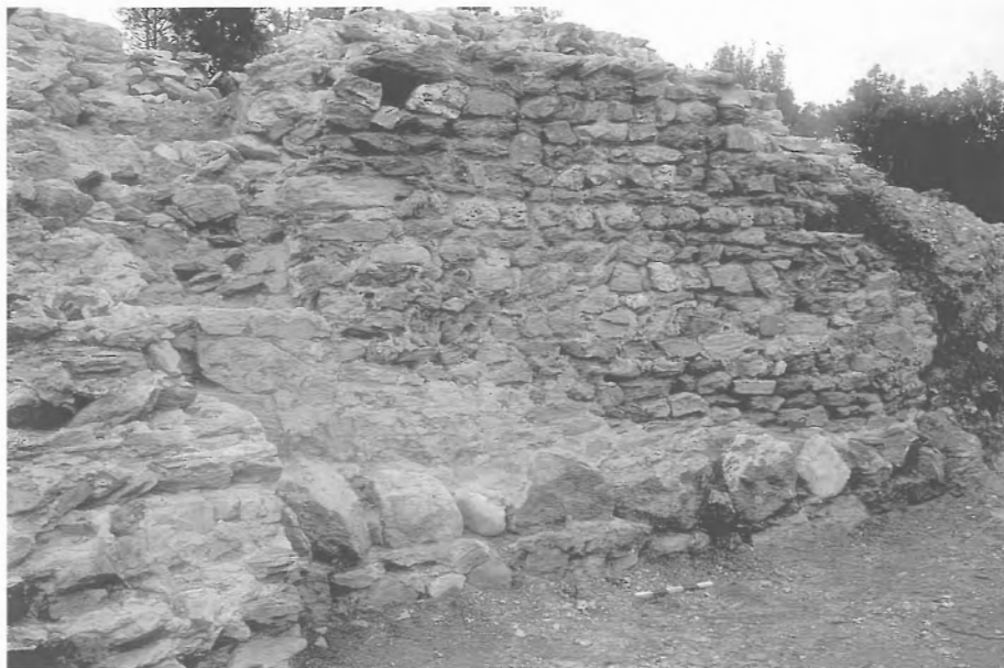
Fig 19. Edifici I. Mur perimetral de migdia i contraforts.
