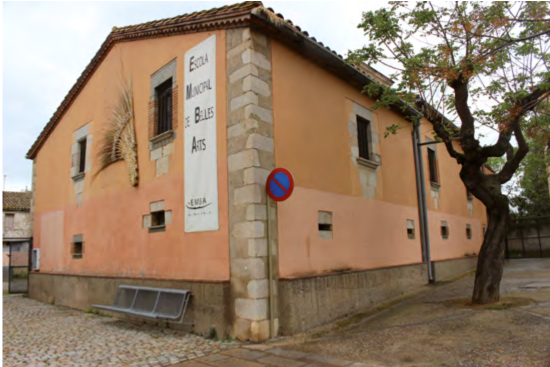
Figura 72. Façana sud-est del mas amb les noves finestres obertes en aquesta fase, excepte la que hi ha més pròxima a la cantonada, que ja s'havia obert en la fase anterior.
