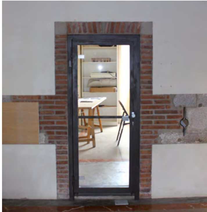
Figura 60. Aspecte actual de la porta que comunicava la sala amb la torre.
