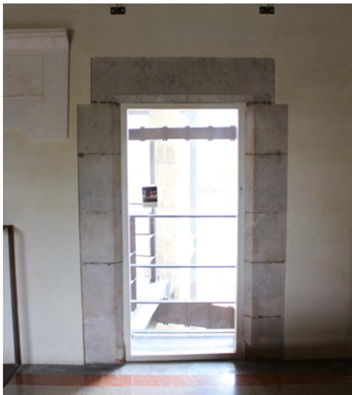
Figura 70. Porta d'accés des de la sala a les noves construccions, ubicades on abans hi havia el pati del mas d'en Benet Llorenç.
