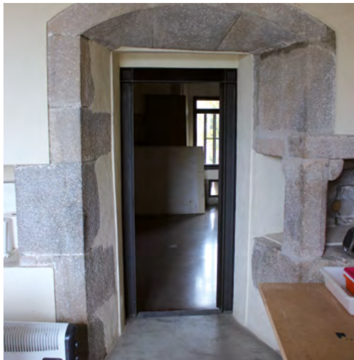
Figura 61. Interior de la porta que connecta la sala vista des de la torre.
