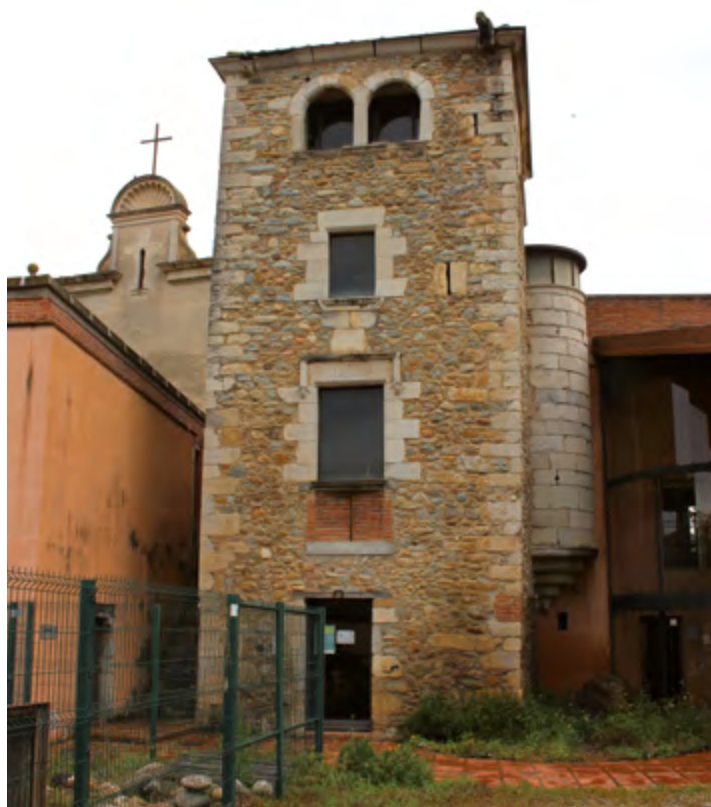
Figura 10. Façana oest de la torre del mas Llorens amb la porta a la planta baixa i una finestra al pis superior, probablement implantada sobre una porta anterior.
