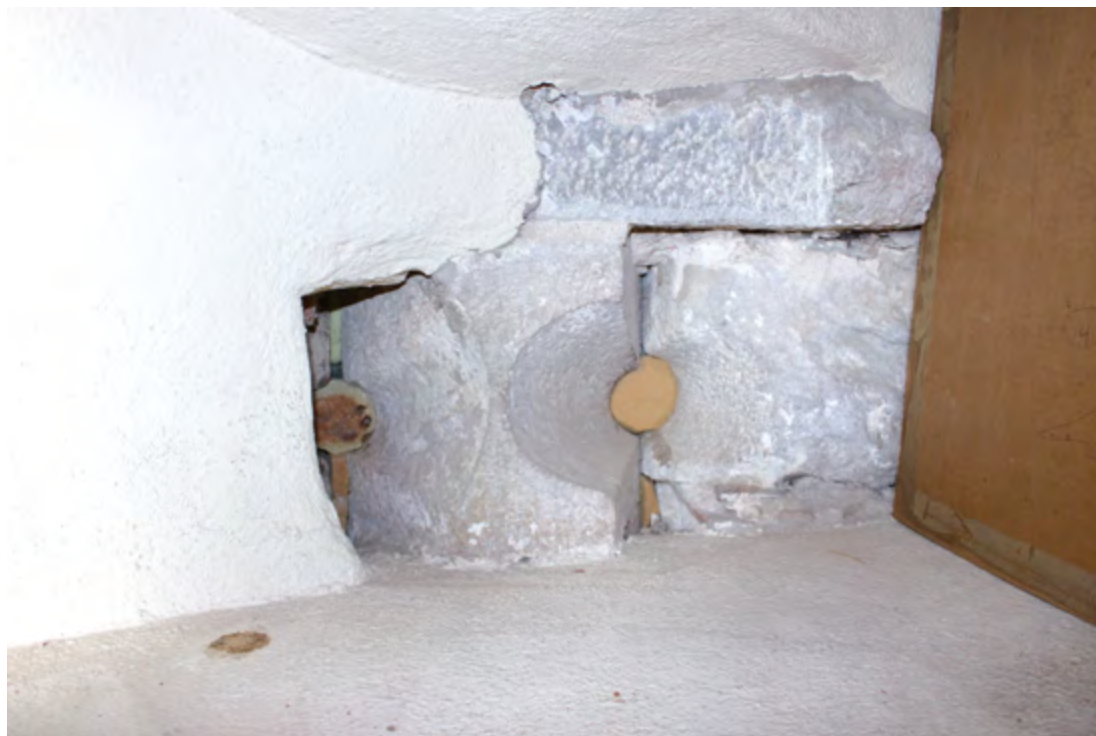
Figura 38. Aspecte actual d'una de les troneres dobles del primer pis de la torre vista des de l'interior.
