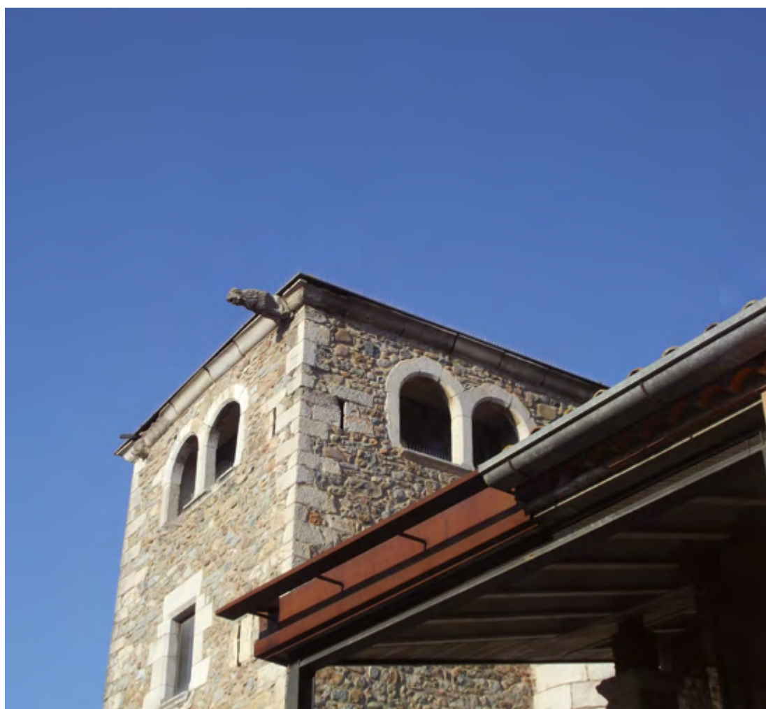
Figura 81. Detall del tester de la torre il·luminat amb arcs aparellats. La cornisa amb motllura de gola i la gàrgola escultòrica també formen part del mateix moment constructiu.
