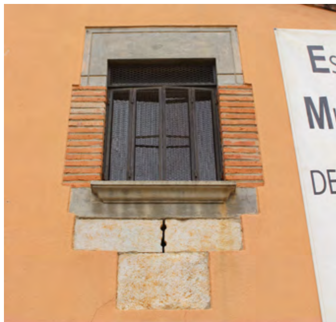
Figura 57. Finestra de la façana sud que il·luminava la cambra situada a migdia de la sala. De l'original només es conserva l'espitllera de la base.
