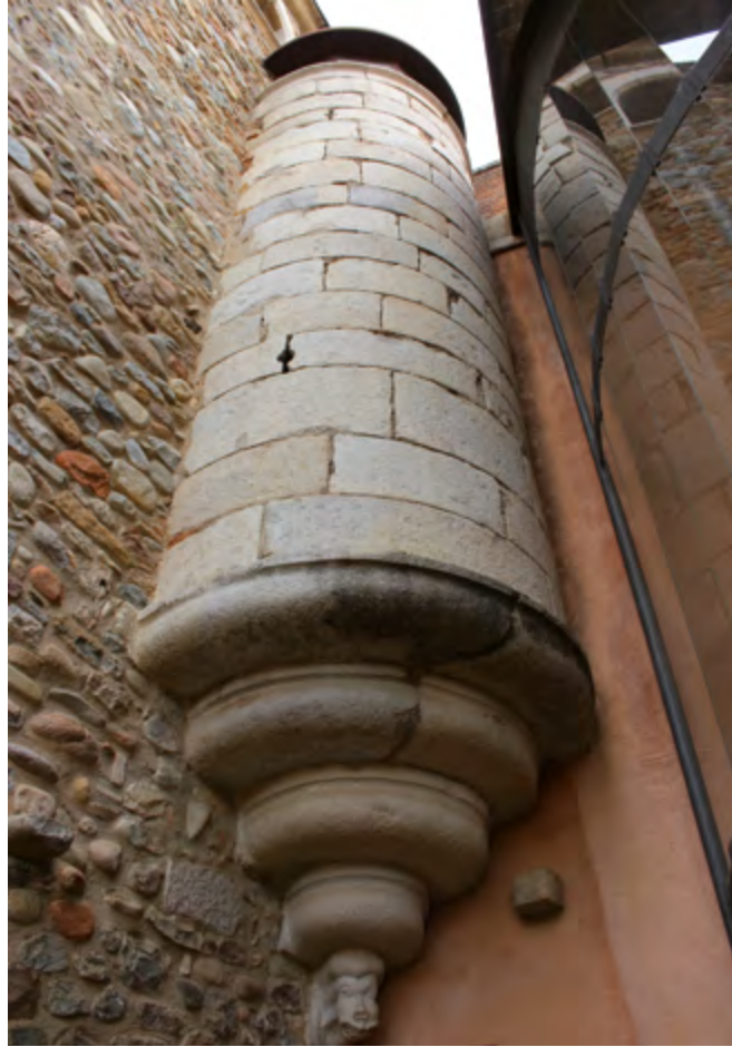
Figura 63. La construcció de la torrella on s'allotja l'escala de cargol va obligar a enderrocar aquell àmbit de la casa forta.
