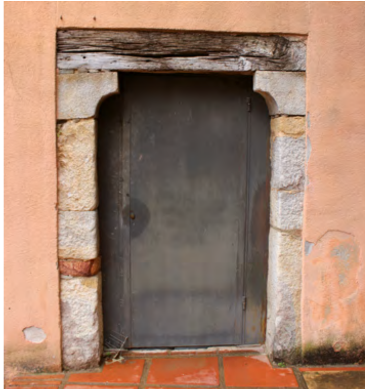
Figura 53. Porta de permòdols que dona accés a la planta baixa del cos nord del mas.
