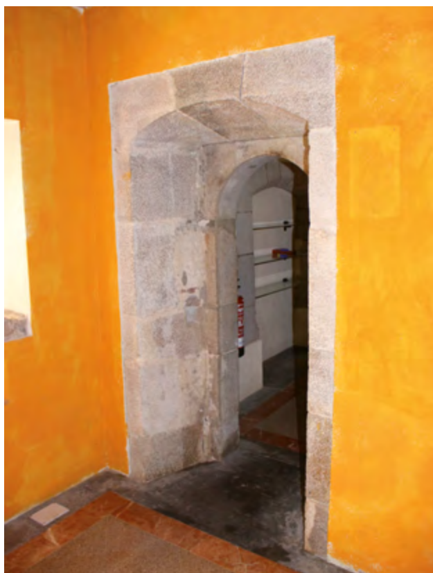
Figura 42. Detall de l'estructura en capialt de la porta que comunica el reducte amb la sala.
