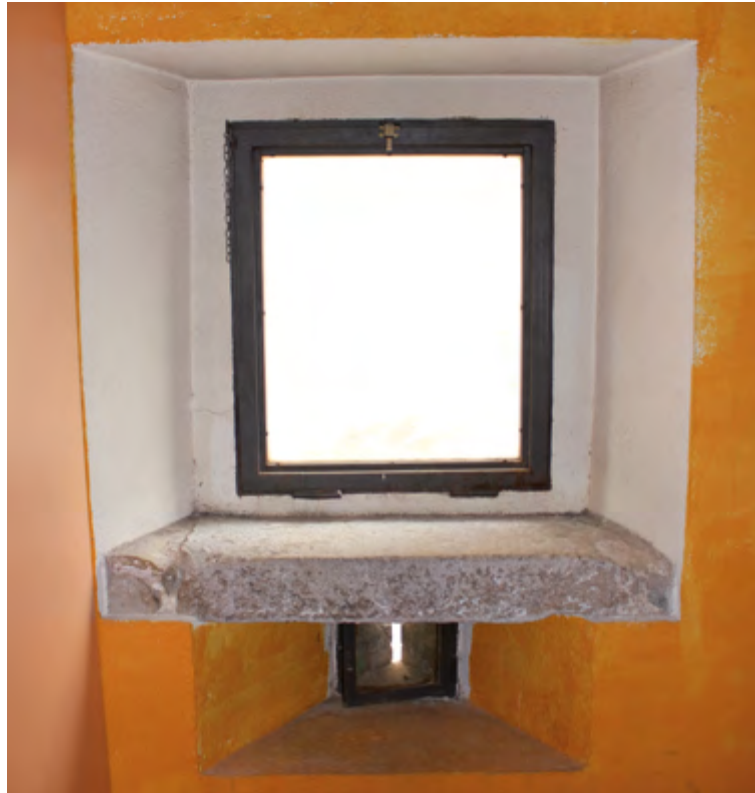
Figura 45. Interior de la finestra de la façana de llevant del reducte.
