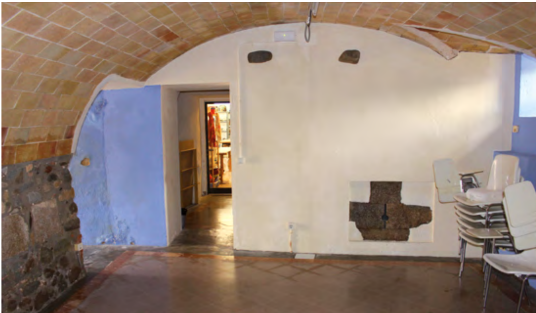
Figura 33. Aspecte actual de la façana sud del reducte a nivell de planta baixa amb l'espitllera.
