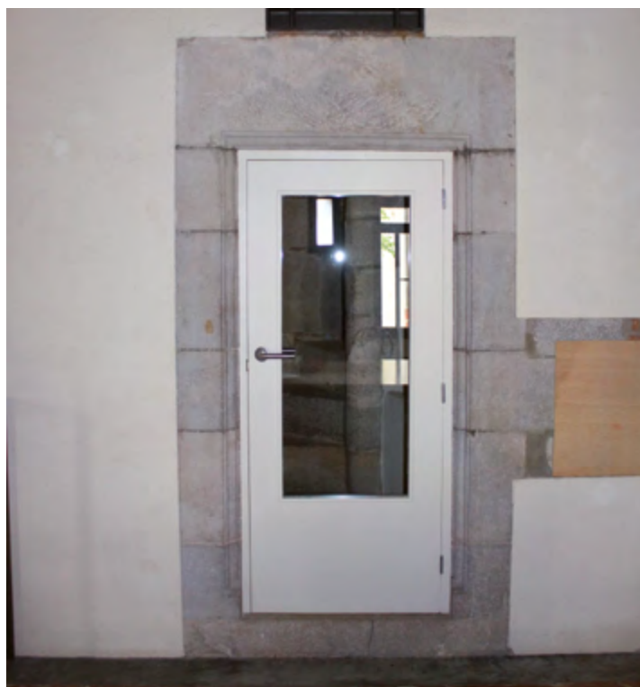
Figura 69. Porta d'entrada a l'escala de cargol des de la sala.
