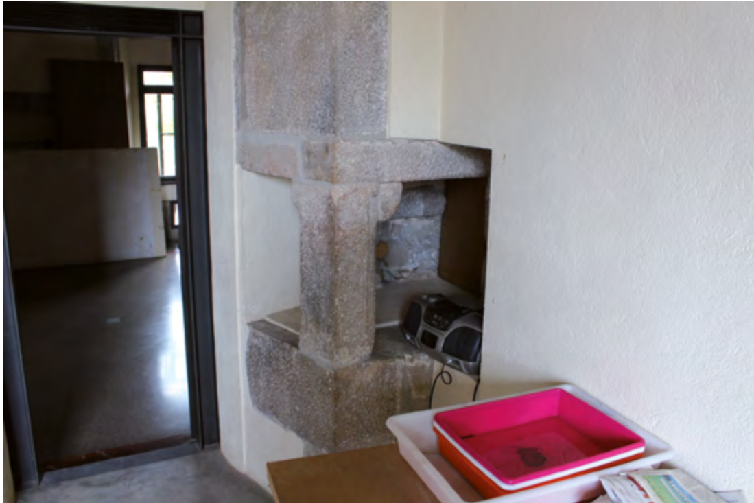
Figura 40. El forat obert a l'angle sud-est de la torre i sustentat amb pilars permetia operar les troneres que apuntaven a la sala.
