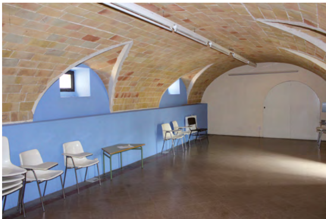
Figura 78. Aspecte actual de la volta que sustenta el paviment de la sala.
