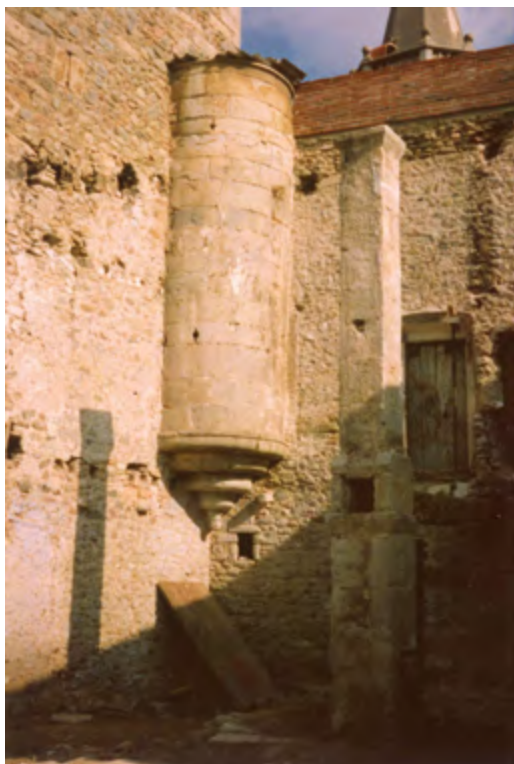
Figura 12. Fotografia realitzada durant la intervenció arqueològica on apareix en detall part de la façana sud de la torre amb la torrera i part del mur oest de la sala encastats al segle XVI. A banda dels forats de biga de sostre tardans practicats al mur de la torre, s'aprecien dues mènsules medievals localitzades a l'alçada de l'arrencament de la torrera. També s'observen dues tècniques constructives diferents a la planta baixa i al tram sobreposat del pany de paret de la sala (foto Museu de l'Aigua).
