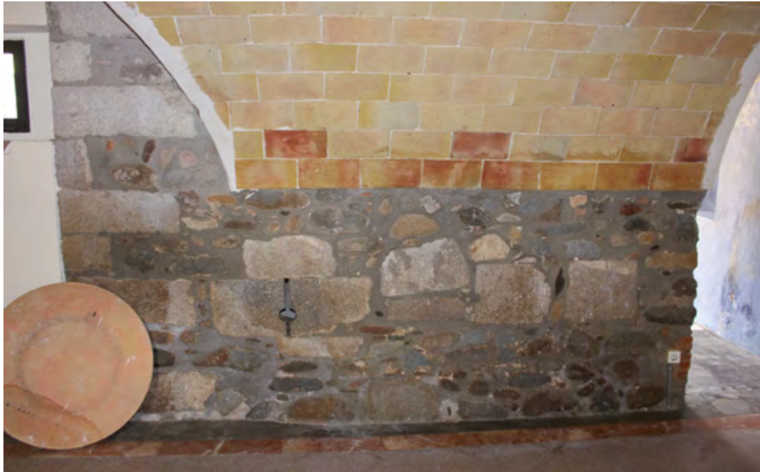
Figura 36. Espitlleres a la base de la façana nord de la torre del mas Llorens.
