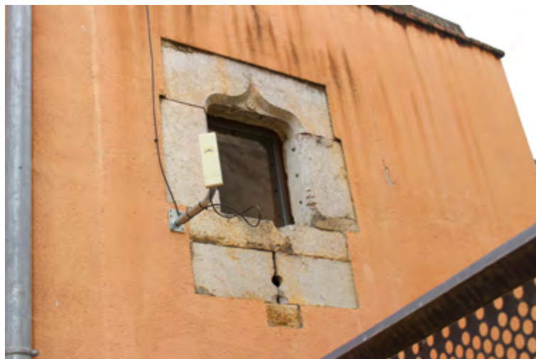
Figura 44. Detall de la finestra del reducte a la façana de llevant.
