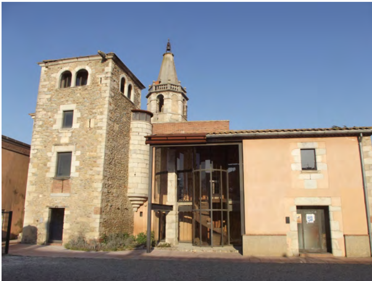
Figura 2. Vista actual del mas Llorens des de ponent. A l'esquerra i dominant el conjunt, la torre i, emergint pel darrere, el campanar de Sant Cugat.
