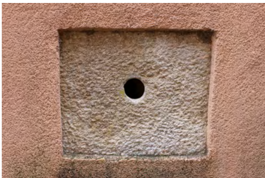
Figura 47. Espiera al costat de l'entrada del cos nord.
