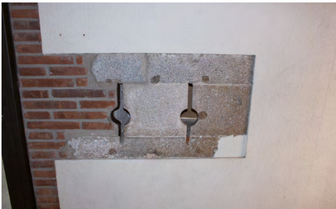
Figura 37. Tronera doble que defensava l'accés a la torre des de la sala.
