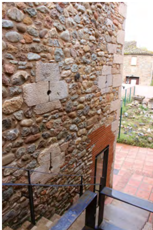
Figura 34. Amb la construcció de l'escala a l'exterior es van afegir noves espitlleres d'arma de foc a la paret nord de la torre.
