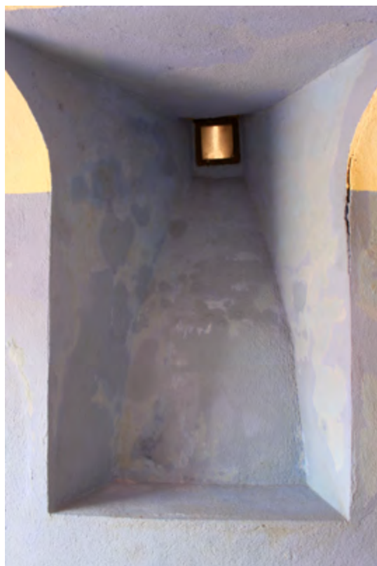
Figura 35. Aspecte d'una espitllera del redut des de l'interior.
