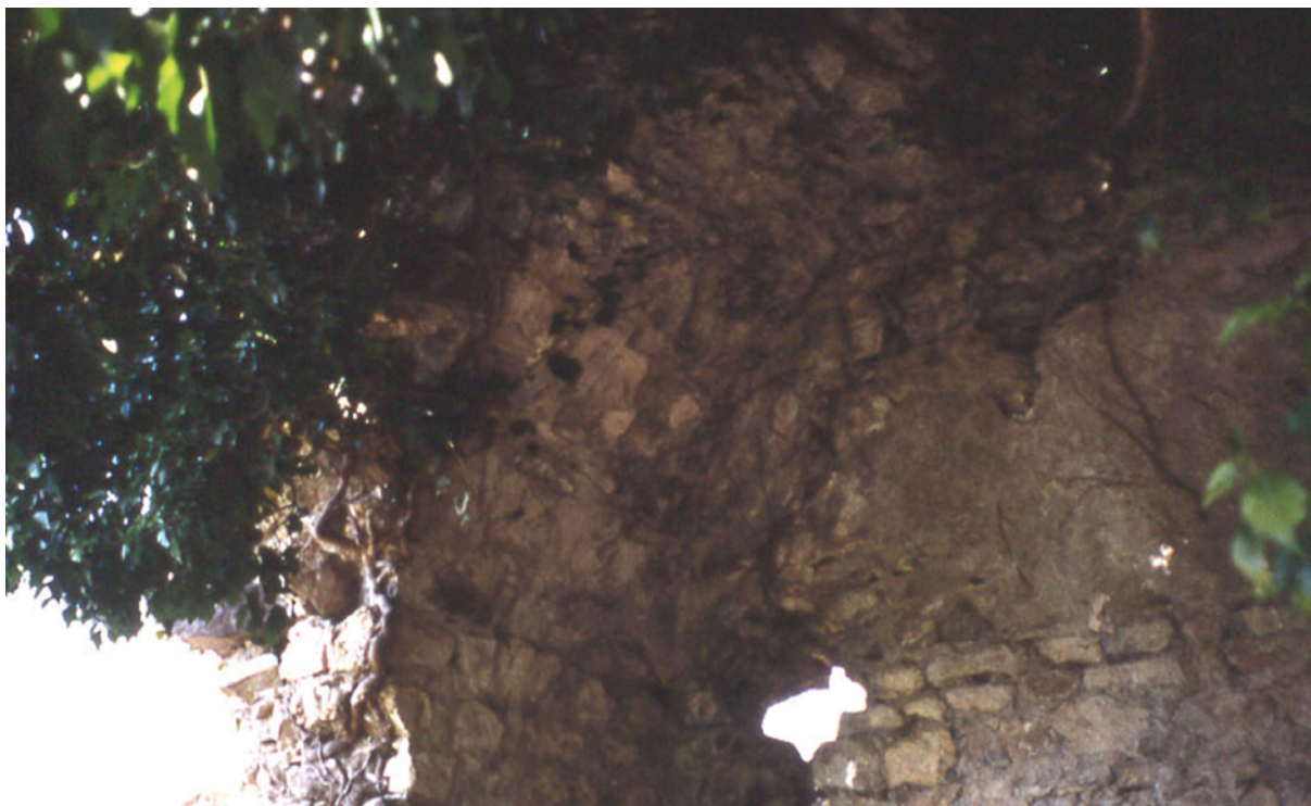
Figura 8. Cavorca II (o can Cavorca). Detall de la volta que cobria l'edifici.
