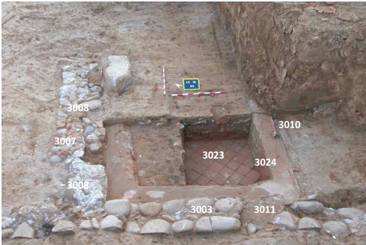
Figura 19. Casa dels Moros (o Cavorca I). Zona 3. Sector S-03. Dipòsit amb sòl de bessales vist des de ponent.
