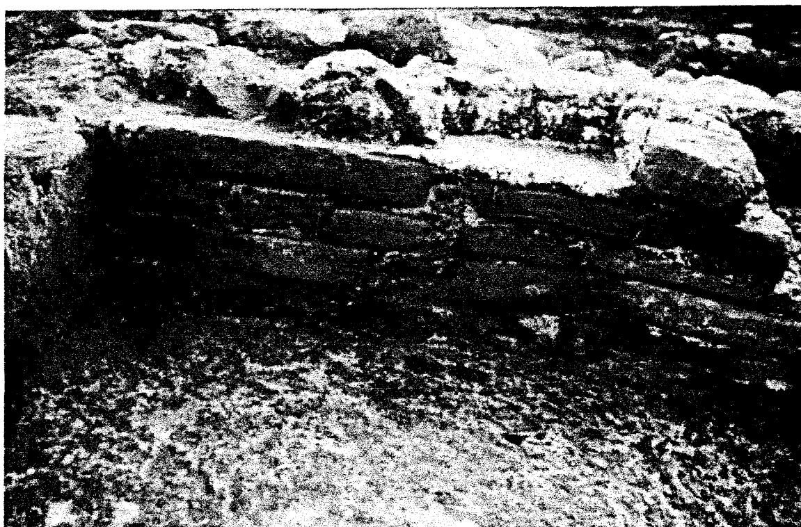
A baix, fig. 14. Detall de la reparació feta amb parament de tegulae que revesteix l'estructura original.
