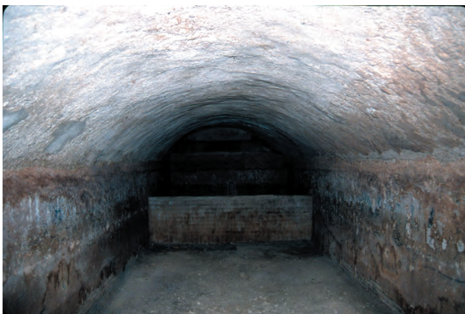
Figura 16. Cubelles. Vista d'una de les quatre cisternes, bastides cap al 200 dC, disposades en bateria al subsòl del castell i que van romandre en ús fins fa pocs anys.
