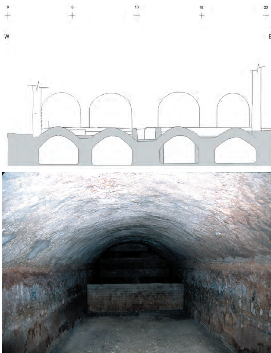
Figura 16. Cubelles. Vista d'una de les quatre cisternes, bastides cap al 200 dC, disposades en bateria al subsòl del castell i que van romandre en ús fins fa pocs anys.
