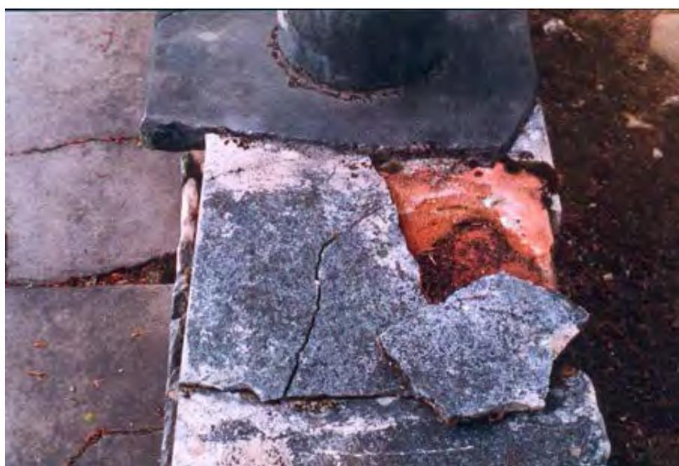
Figure 7. *Villa de Montmaurin* (France, Haute-Garonne) : éclatement de l'enrobage d'une galette de béton suite à l'action de l'humidité dans les thermes (R. Dupont).
