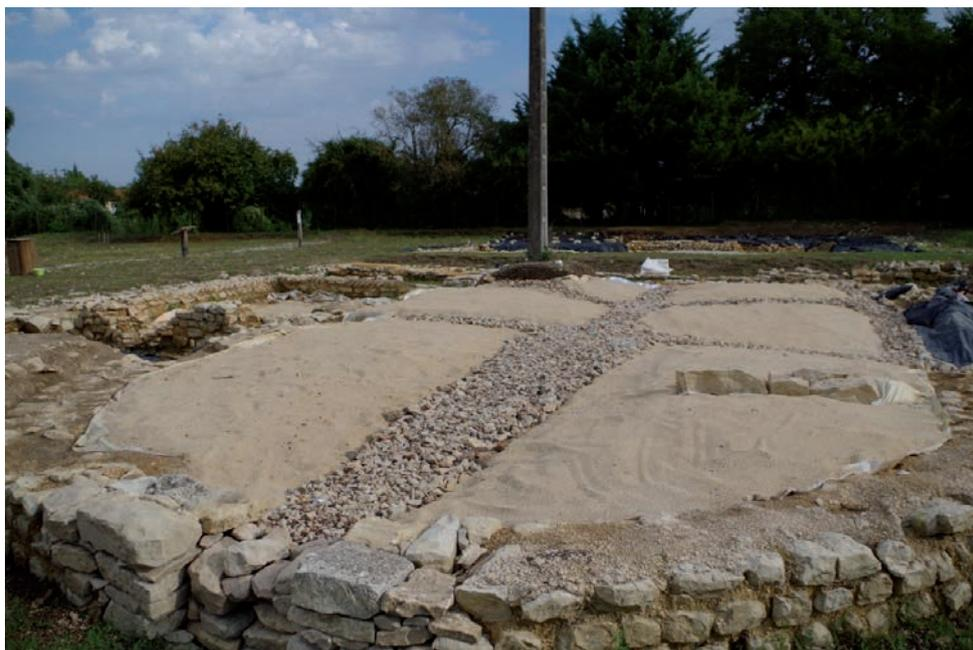
7. Le sable utilisé est de nature siliceuse ou silico-calcaire afin d'éviter tout facteur chimique de dégradation. Dans ce contexte, le sable de mer ou le «sable à lapin» est proscrit.
