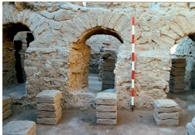
Figure 7. Les trois voûtes souterraines entre les *caldarium* et le *tepidarium*. Photo Actium.
