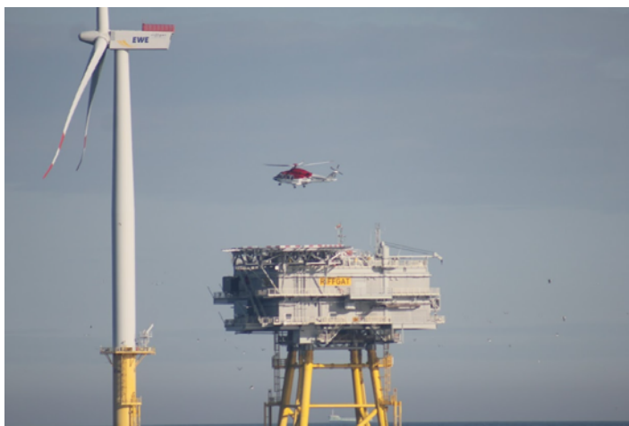
FIGURA 10. Infraestructura offshore vinculada a parques eólicos marinos, cuya operación requiere regulaciones específicas para minimizar impactos ambientales Fuente: Vanessa Stelzenmüller (Institute of Sea Fisheries, Alemania).
