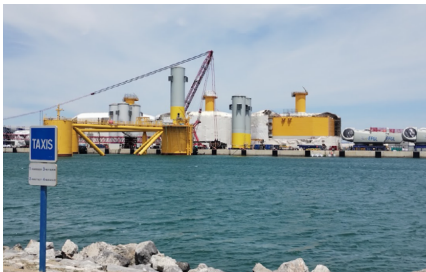
FIGURA 12. Infraestructuras portuarias asociadas al ensamblaje de un aerogenerador flotante en Port-la-Nouvelle (Francia), un elemento complementario clave que debe incluirse en la evaluación de impactos acumulados. Fuente: Proyecto BIOPAÍS.
