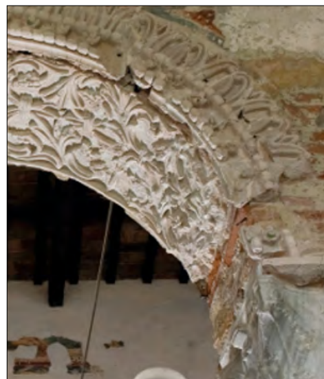
Fig. 5: particolare di un arco decorato in stucco della chiesa di San Salvatore a Brescia (foto SR)
