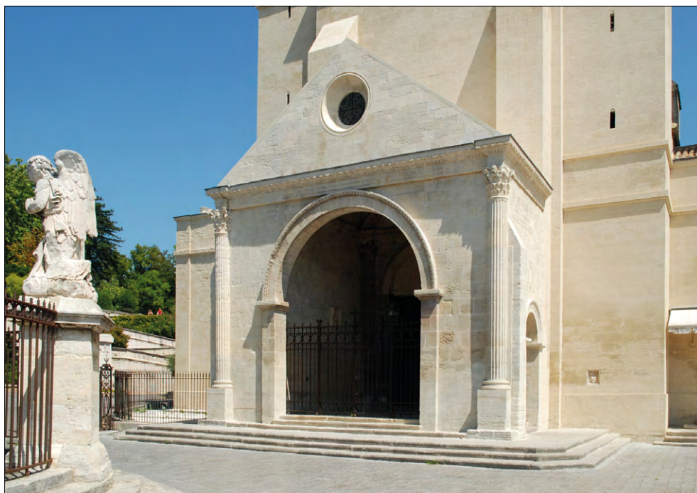
Fig. 2 : Détail de la façade de Notre-Dame-des-Doms, Avignon
