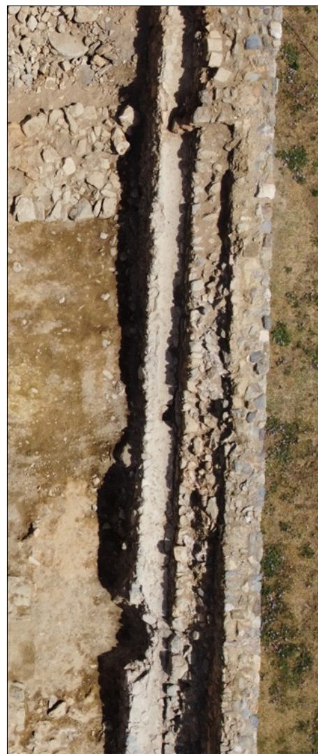
Figura 8. Detall de la muralla est amb un doble parament (el tercer element correspon a una claveguera interior del segle XVIII).
