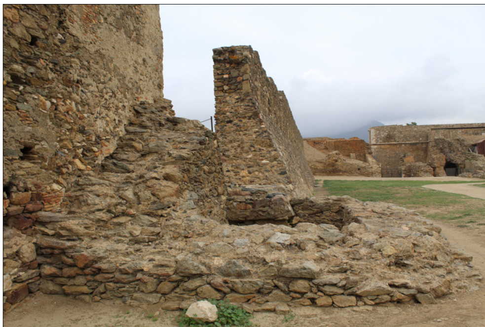
Figura 5. Torre quadrangular de l'extrem est, on s'aprecia com es recolza contra el tram de muralla amb escarpa.
