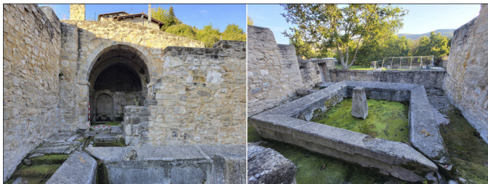
Figura 2. Fuente de Treviño. A la izquierda, una vista general de la estructura hidráulica. A la derecha, detalle del abrevadero de su zona exterior.
