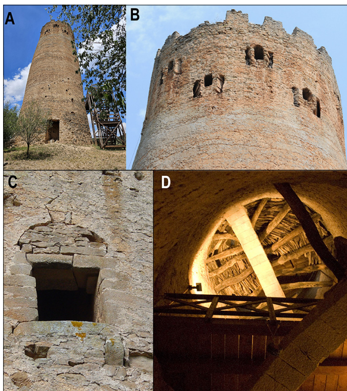
Figura 6. Vallferosa. A. vista general (A. Pancorbo); B. detall dels cadafals (J. A.: Adell); C. porta de l'anella exterior (J. Menchón); D. interior de la torre (J. Menchón).
