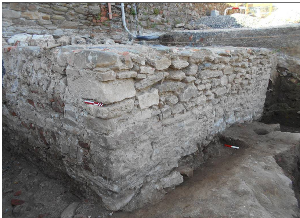
Fig 4. Dettaglio della muratura di un contrafforte.
