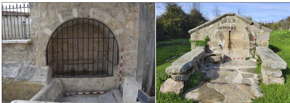
Figura 10. A la izquierda puede observarse una vista general de la fuente de Wamba. A la derecha puede observarse una vista general de la fuente de Guadramiro.
