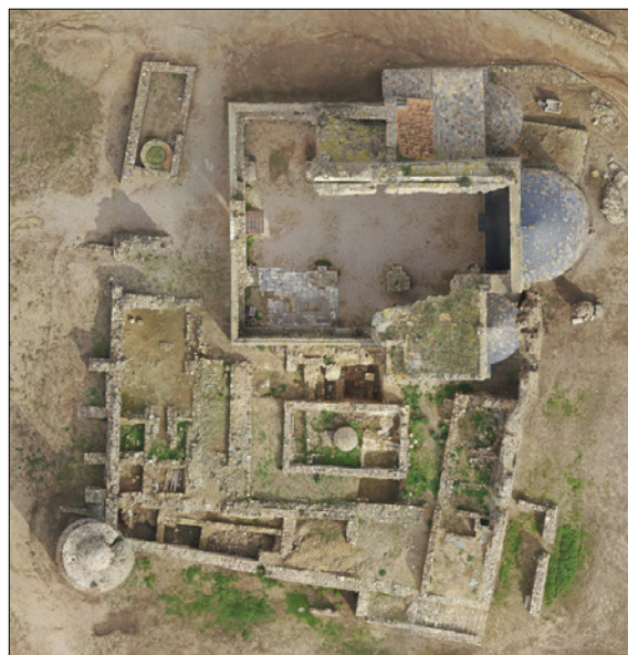
Figura 2. Vista general del monestir de Santa Maria de Roses.
