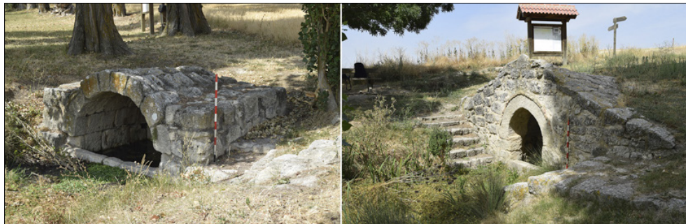
Figura 6. Dos de las estructuras hidráulicas de Tiedra. A la izquierda puede observarse una vista general de la fuente de Antagueros. A la de derecha puede observarse una vista general de la Pelilla.
