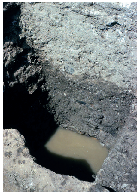
Figura 1.8. Ciutadella de Roses. «Edifici A», habitació G-VI. Mur de ponent de l'estanca, d'opus coementicium; al fons, l'aigua de la capa freàtica (juliol de 1979).
